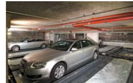
Viene fatta traslare verso l'elevatore con movimenti in sequenza
