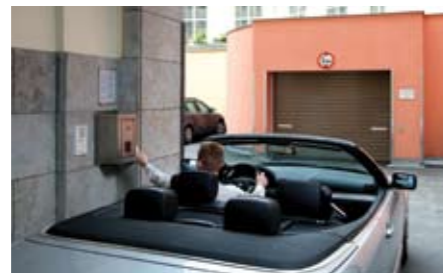
L'utente attiva la procedura di parcheggio tramite il suo chip induttivo al pannello di comando.
