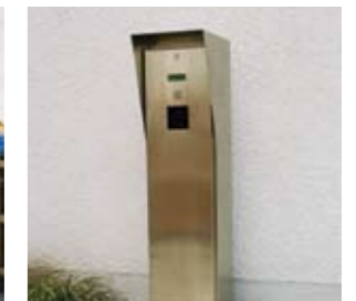
La selezione del posto auto avviene tramite chip induttivo al pannello di comando situato in prossimità dell'area di trasferimento.
