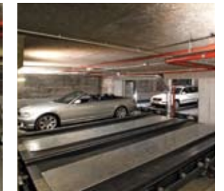
L'elevatore solleva la vettura e la porta al locale di ricevimento.
